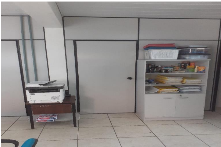
Porta 02 – Colocação de vidro
